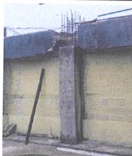
Mantenimiento de salón de audiovisuales con Suministro ó Dotación de materiales metálicos VIGA W18X35 x 20pies ASTM A36 para entepiso prefabricado metálico en segundo nivel módulo 3
