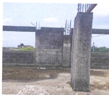
Mantenimiento de salón de audiovisuales con Suministro ó Dotación de materiales metálicos VIGA W18X35 x 20pies ASTM A36 para entepiso prefabricado metálico en segundo nivel módulo 3
