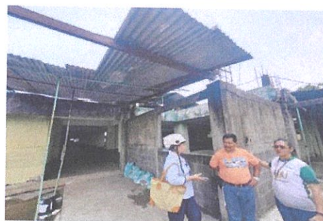
Mantenimiento de salón de audiovisuales con Suministro ó Dotación de materiales metálicos VIGA W18X35 x 20pies ASTM A36 para entepiso prefabricado metálico en segundo nivel módulo 3
