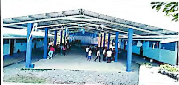
FOTO 2: sustitución de capote Maxalum calibre 28.
