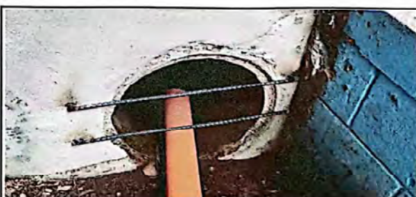
FOTO 6: sustitución de cuneta de concreto.
