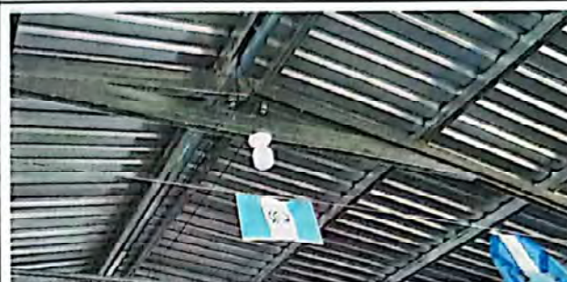
FOTO 8: sustitución de bombillas Led Globo 30 W.
