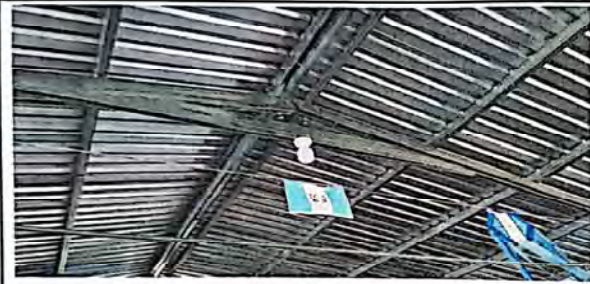
FOTO 3: sustitución de estructura de soporte de madera por metal.
