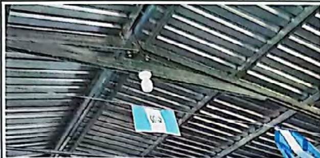
FOTO 7: sustitución de plafoneras.
