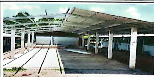
FOTO 2: sustitución de capote Maxalum calibre 26.
