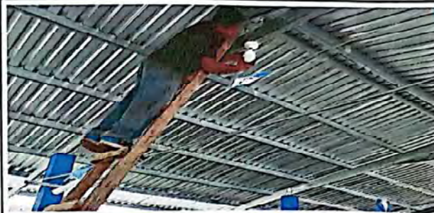
FOTO 8: sustitución de bombillas Led Globo 30 W.
