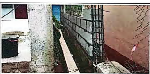
FOTO 6: sustitución de cuneta de concreto.
