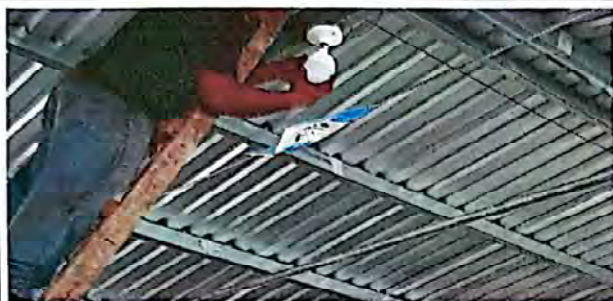
FOTO 7: sustitución de plafoneras.
