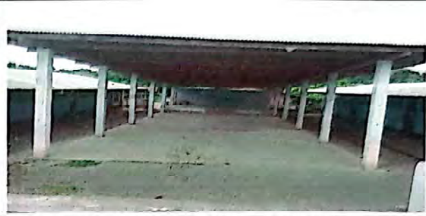
FOTO 2: sustitución de capote Maxalum calibre 26.
