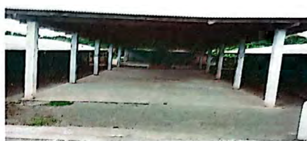
FOTO 8: sustitución de bombillas Led Globo 30 W.
