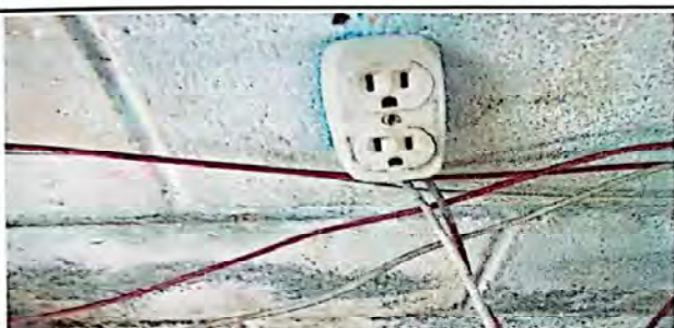
FOTO 9: reparación de cableado eléctrico calibre 14 AWG.
