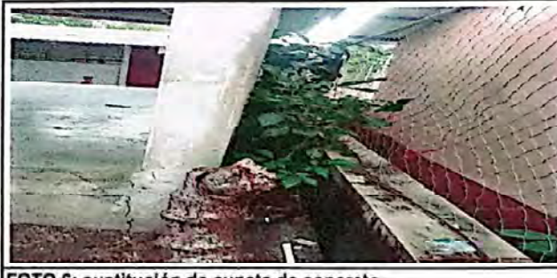
FOTO 6: sustitución de cuneta de concreto.
