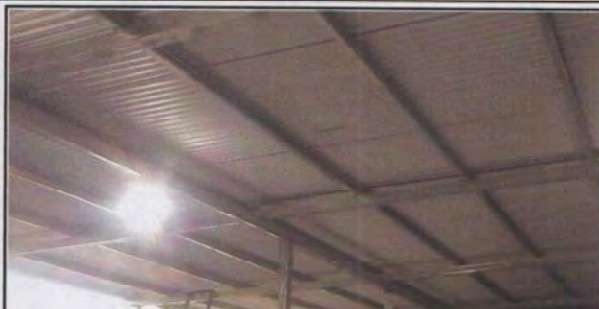
Foto 1: Sustitución de ducto eléctrico y accesorios.
