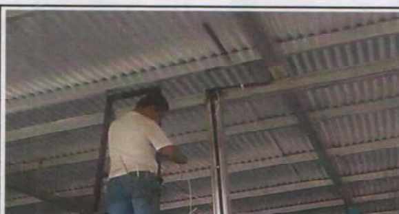
Foto 4: Instalación de unidades luz (incluye interruptor, ducto y cable eléctrico).
