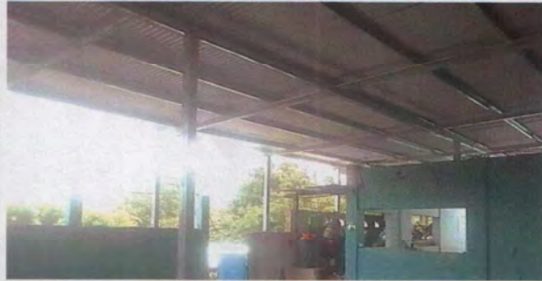
Foto 5: Sustrucción de estructura metálica galvanizada.
