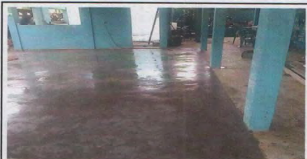
Foto 3: Sustitución de piso de torta de concreto.
