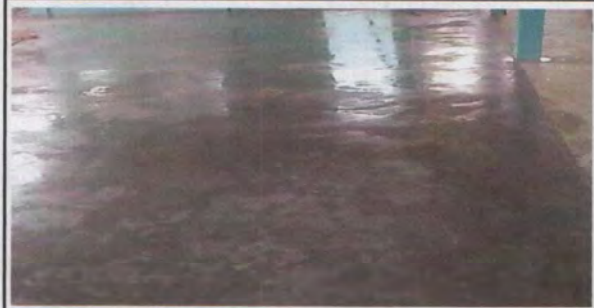
Foto 6: Reparación de plancha de concreto de patio.
