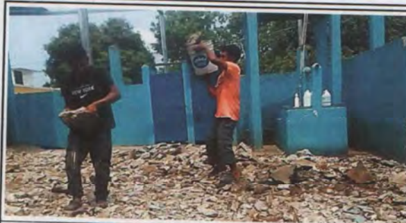
Foto 6: Reparación de plancha de concreto de patio.
