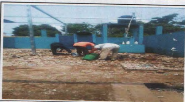
Foto 3: Sustitución de piso de torta de concreto.
