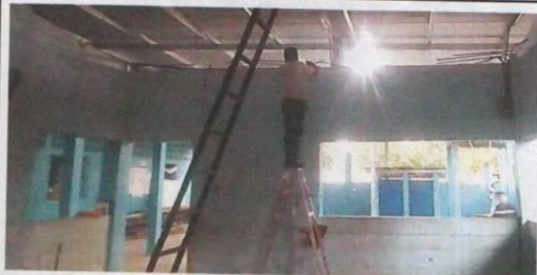
Foto 1: Sustitución de ducto eléctrico y accesorios.
