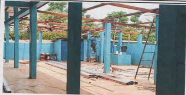
Foto 5: Sustrucción de estructura metálica galvanizada.
