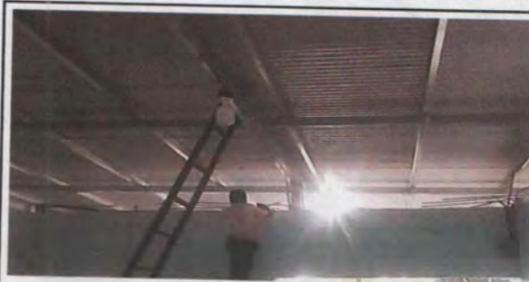
Foto 4: Instalación de unidades luz (incluye interruptor, ducto y cable eléctrico).
