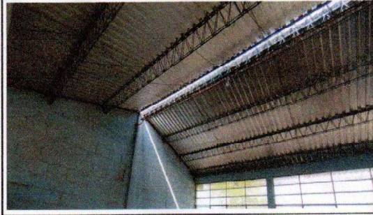
Foto 2: Sustitución de lámina, por lámina troquelada aluzinc calibre 26 FINALIZADO
