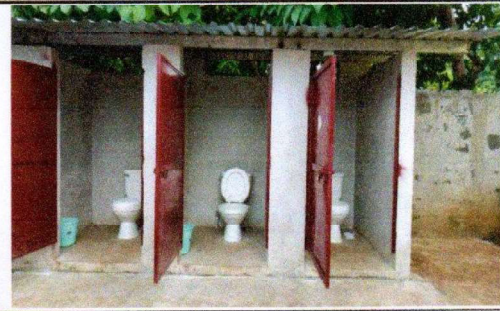
Foto 4: cambio de techo y estructura de baños , colocación de piso, instalación de 3 tasas sin azulejo
