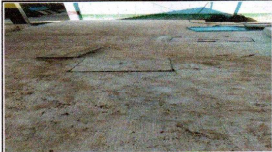
Foto 6: SUSTITUCION DE TORTA DE CONCRETO A PISO DE BAÑOS FINALIZADO
