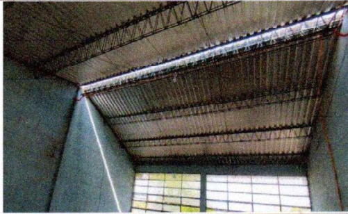
Foto 1: Sustitución de lámina, por lámina troquelada aluzinc calibre 26 FINALIZADO
