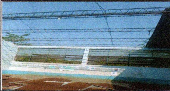
Foto 1: Instalacion de lamina troqueleada aluzinc calibre 26
