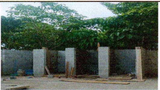
Foto 4: cambio de techo y estructura de baños , colocación de piso y azulejos en baños
