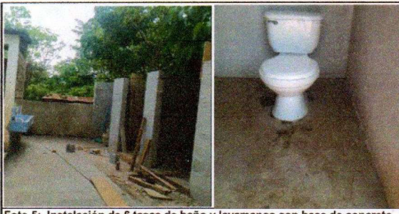
Foto 5: Instalación de 6 tasas de baño y lavamanos con base de concreto con azulejo
