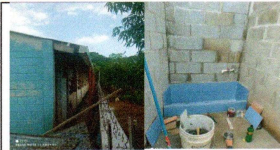
Foto 3: Reparacion de muro de block reforzado en paredes del baño,fabricacion de mejorito ,
