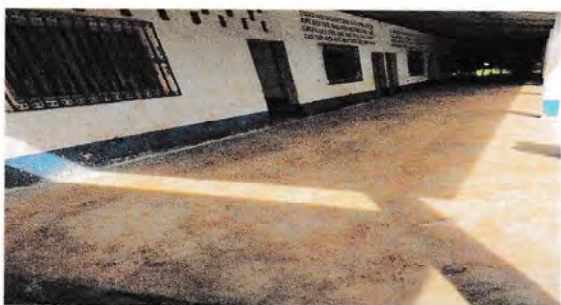
Foto 3: Sustrucción de piso de concreto
