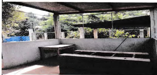
Foto 2: Suministro e instalación de paredes de cocina, reparación de estufa rural
