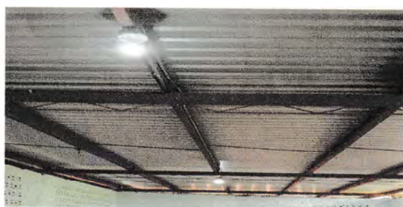
Foto 5: Reparación de sistema eléctrico
