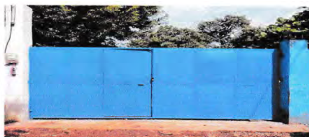
Foto 1: Sustrucción de portón metálico
