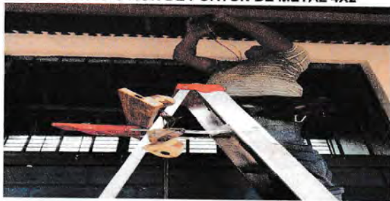
Foto 5: Reparación de sistema eléctrico
