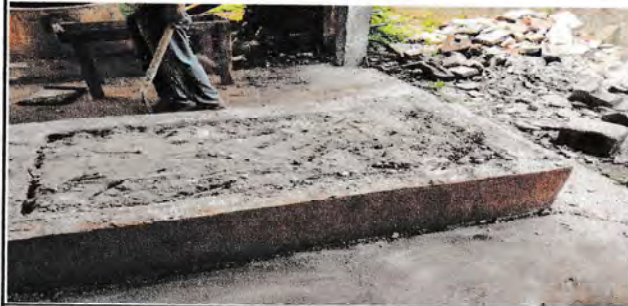
Foto 2: Suministro e instalación de paredes de cocina, reparación de estufa rural
