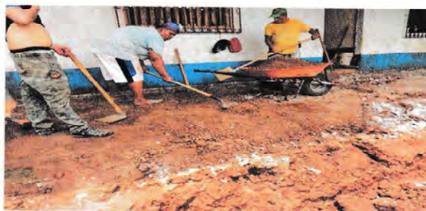
Foto 3: Sustrucción de piso de concreto
