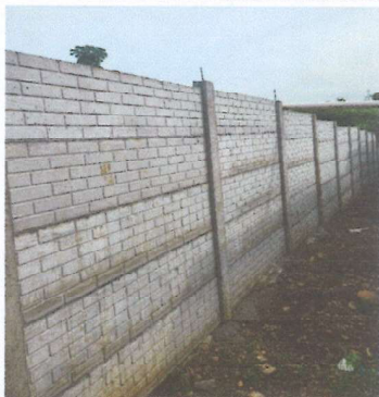
Sustitucion de muro perimetral con prefabricados de concreto reforzado H=2.5m
