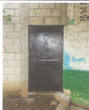
Mantenimiento a puerta de cocina
