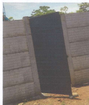
Suministro e instalación de porton metalico
