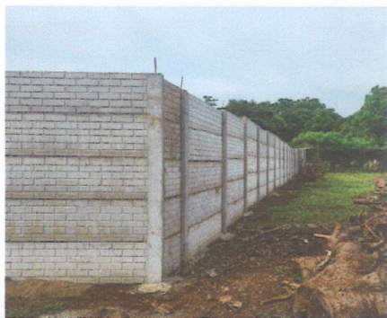
Sustitucion de muro perimetral con prefabricados de concreto reforzado H=2.5m
