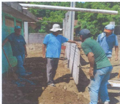
Sustitucion de muro perimetral con prefabricados de concreto reforzado H=2.5m
