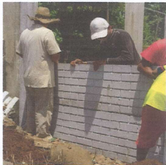
Sustitucion de muro perimetral con prefabricados de concreto reforzado H=2.5m
