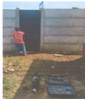
Suministro e instalación de portón metalico
