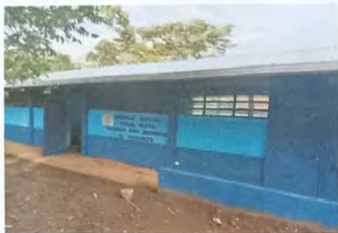
Foto 1: SUMINISTRO E INSTALACION DE LAMINA TROQUELADA C 26
