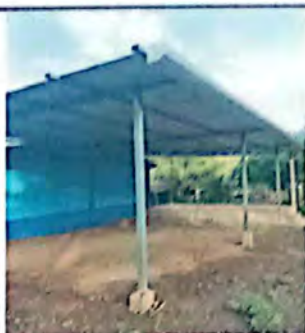
Foto 3: SUSTITUCION E INSTALACION DE LAMINA ALUZINC TROQUELADA C28 EN SALON
