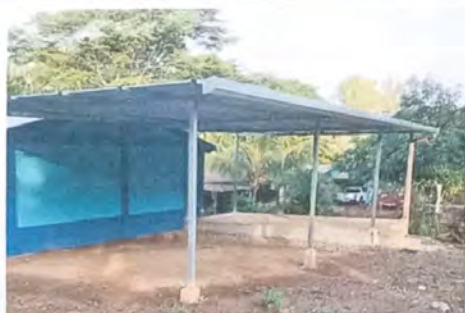
Foto 5: SUMINISTRO E INSTALACIÓN DE BASE METÁLICA PARA SOPORTE DE ESTRUCTURA DE SALON
