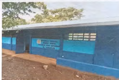
Foto 4: APLICACIÓN DE PINTURA EN PAREDES
