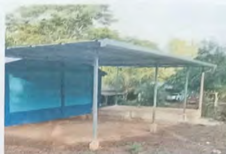
Foto 2: INSTALACION DE ESTRUCTURA METALICA GALVANIZADA EN SALON
