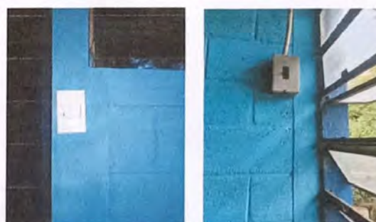
Foto 6: REPARACION DE SISTEMA ELECTRICO DE AULAS
