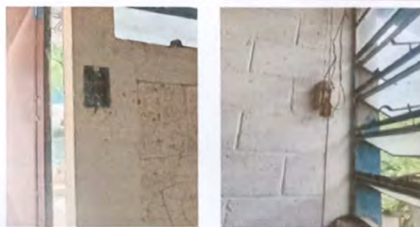
Foto 6: REPARACION DE SISTEMA ELECTRICO DE AULAS
