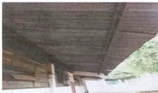
Foto 5: MANTENIMIENTO A ESTRUCTURA DE SOPORTE
