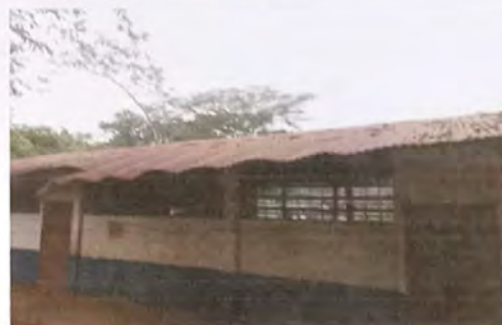
Foto 4: APLICACIÓN DE PINTURA EN PAREDES
