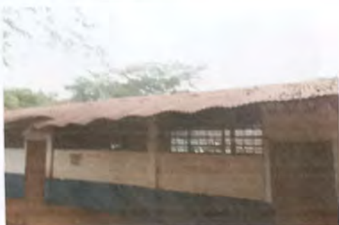
Foto 1: SUMINISTRO E INSTALACION DE LAMINA TROQUELADA C 26
