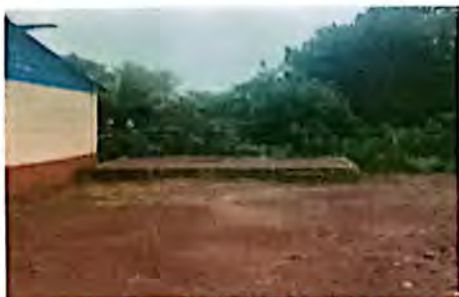
Foto1: REPARACION DE TORTA DE CONCRETO DE ESCENARIO
