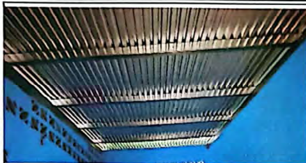
Foto 1: Sustrucción de estructura metálica
