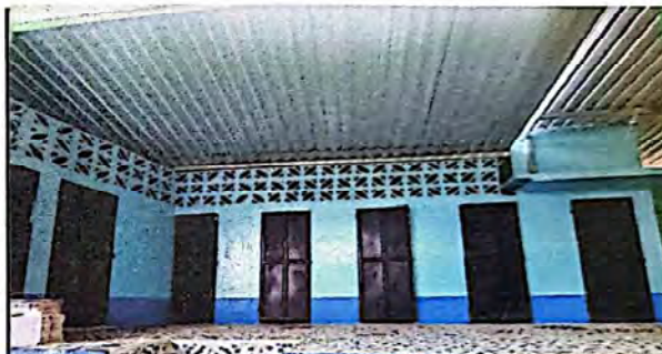
Foto 4: Sustrucción de lámina troquelada
