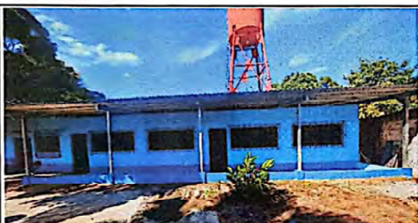
Foto 3: Sustrucción de lámina troquelada
