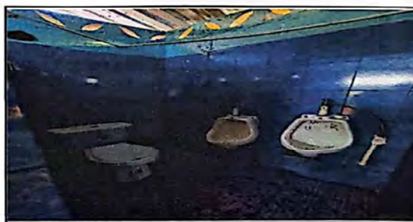
Foto 6: Sustrucción de mingitorio
