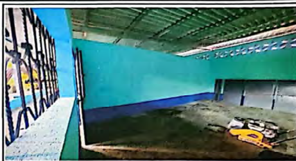
Foto 2: Reparación de muro de aulas
