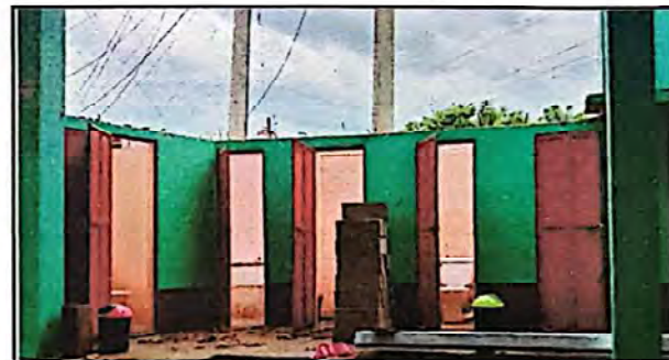
Foto 4: Sustrucción de lámina troquelada
