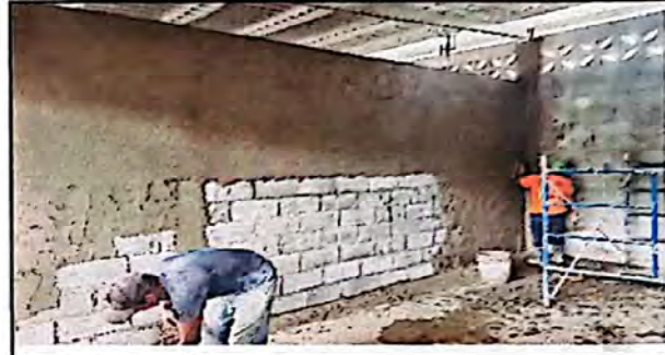
Foto 2: Reparación de muro de aulas
