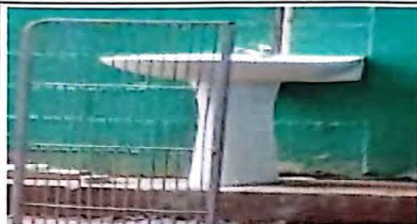
Foto 7: Suministro de lavamanos y accesorios
