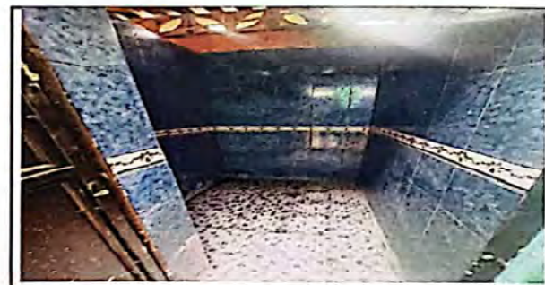
Foto 6: Sustrucción de mingitorio
