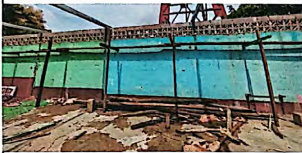
Foto 1: Sustrucción de estructura metálica
