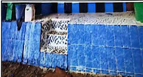
Foto 8: Suministro de piso rubik
