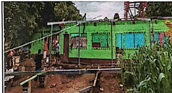
Foto 3: Sustrucción de lámina troquelada
