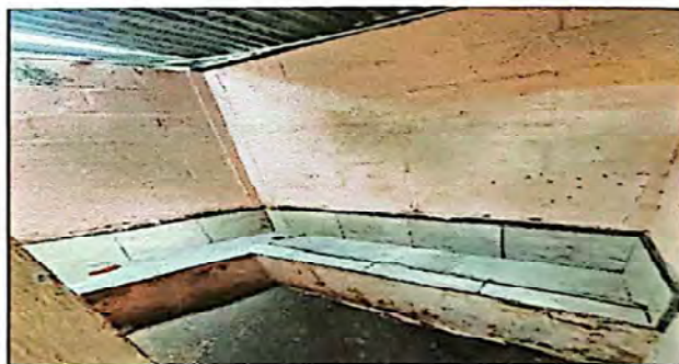
Foto 6: Sustitución de mingitorio
