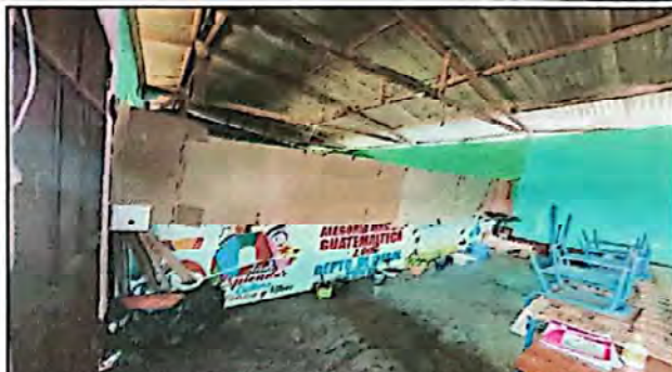
Foto 2: Reparación de muro de aulas
