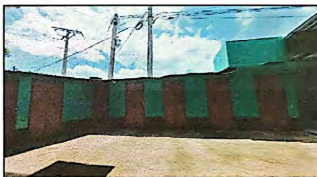
Foto 4: Sustitución de lámina troquelada
