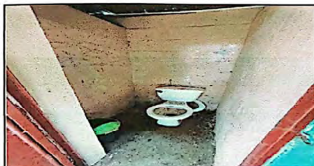
Foto 5: Sustitución de sanitario
