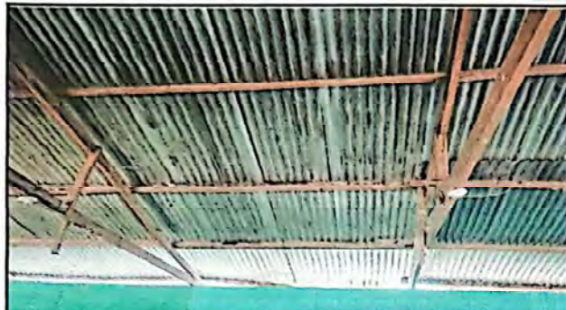
Foto1: Sustitución de estructura metálica
