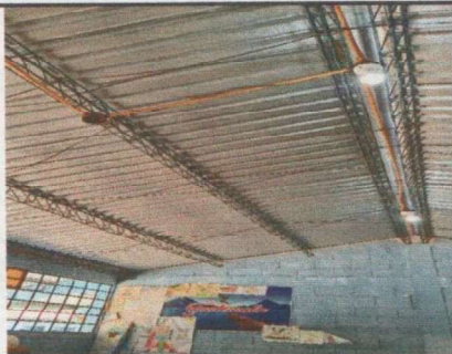
Foto 3: SUSTITUCIÓN DE ESTRUCTURA DE HIERRO POR ESTRUCTURA METÁLICA
