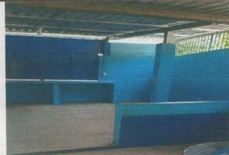
Foto 6: REPARACIÓN DE GABINETES DE COCINA
