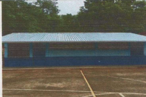
Foto 2: SUSTITUCIÓN DE COBERTURA DE LAMINA ACANALADA POR LAMINA TROQUELADA
