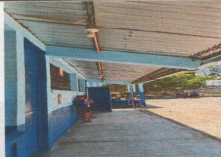
Foto 4: SUSTITUCIÓN DE ESTRUCTURA DE HIERRO POR ESTRUCTURA METÁLICA
