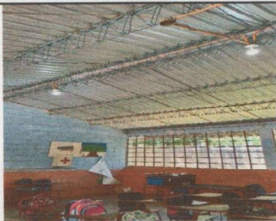
Foto 1: REPARACIÓN SISTEMA ELÉCTRICO
