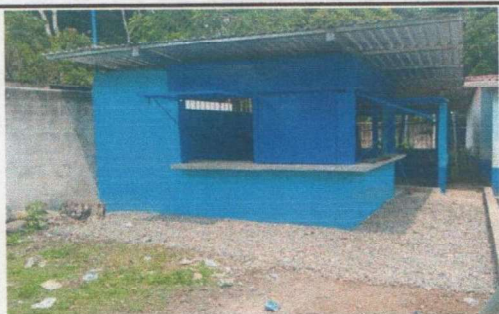
Foto 5: REPARACIÓN PARED DE COCINA
