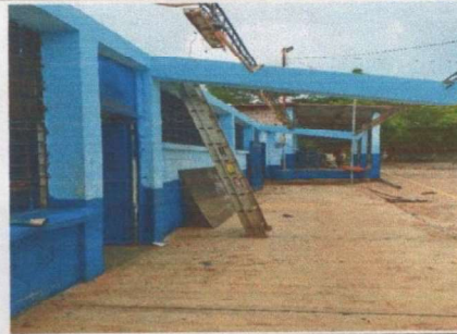
Foto 4: SUSTITUCIÓN DE ESTRUCTURA DE HIERRO POR ESTRUCTURA METÁLICA
