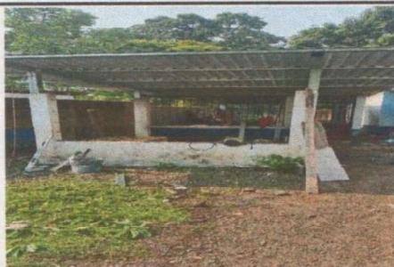
Foto 5: REPARACIÓN PARED DE COCINA
