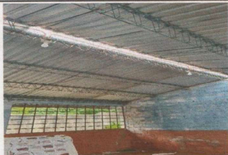
Foto 3: SUSTITUCIÓN DE ESTRUCTURA DE HIERRO POR ESTRUCTURA METÁLICA
