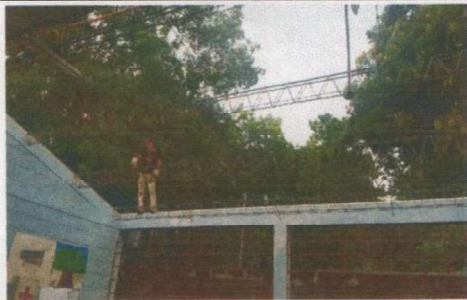
Foto 1: REPARACIÓN SISTEMA ELÉCTRICO
