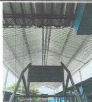
INSTALACION DE CUBIERTA METALICA, LAMINA TROQUELADA CALIBRE 26
