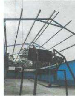
INSTALACION DE ESTRUCTURA METALICA
