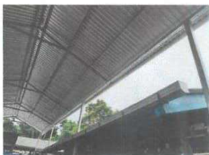
SUSTITUCION DE CANALES DE AGUA PLUVIAL
