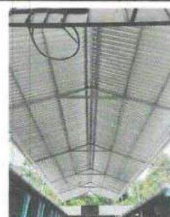
INSTALACION DE CUBIERTA METALICA, LAMINA TROQUELADA CALIBRE 26
