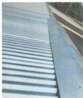
SUSTITUCION DE LAMINA ACANALADA CALIBRE 26
