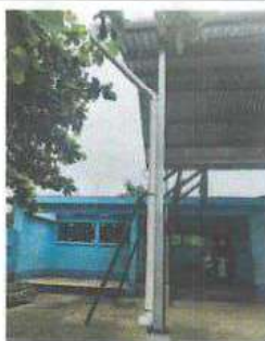
SUSTITUCION DE CANALES DE AGUA PLUVIAL
