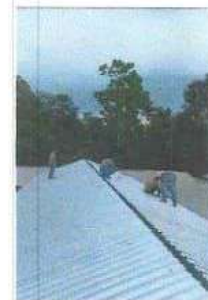
INSTALACION DE CUBIERTA METALICA, LAMINA TROQUELADA CALIBRE 26
