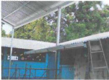
SUSTITUCION DE CANALES DE AGUA PLUVIAL
