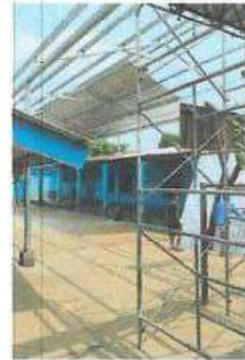
INSTALACION DE CUBIERTA METALICA, LAMINA TROQUELADA CALIBRE 26
