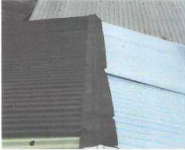
SUSTITUCION DE LAMINA ACANALADA CALIBRE 26
