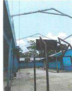
INSTALACION DE ESTRUCTURA METALICA
