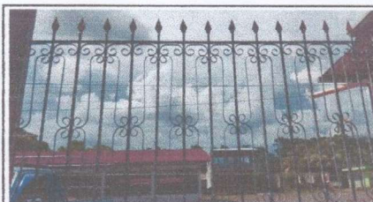
Foto 4: Suministro e instalación de balcones
