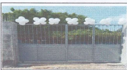
Foto 6: Suministro e instalación de porton metalico
