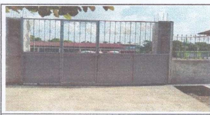
Foto 5: Suministro e instalación de porton metalico
