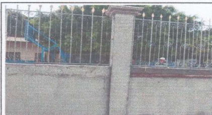
Foto 3: Suministro e instalación de balcones
