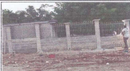
Foto 2: sustitución de pared perimetral con muro de manopostería reforzada con zapata de 1x1 metro
