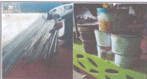
Foto 3: Suministro e instalación de balcones
