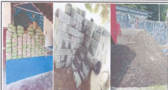
Foto 1: sustitución de pared perimetral con muro de manopostería reforzada con zapata de 1x1 metro
