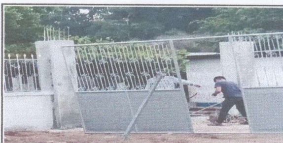
Foto 6: Suministro e instalación de porton metalico
