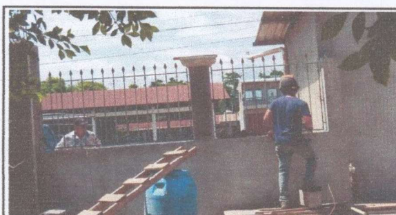
Foto 4: Suministro e instalación de balcones
