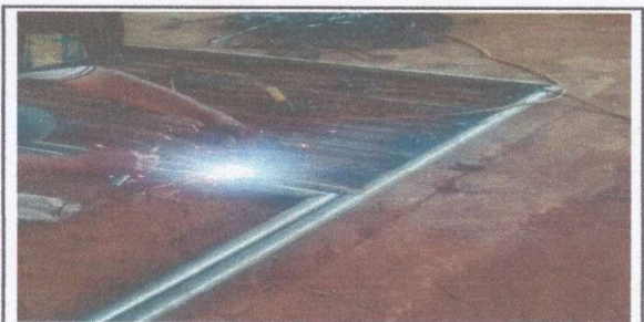
Foto 5: Suministro e instalación de porton metalico
