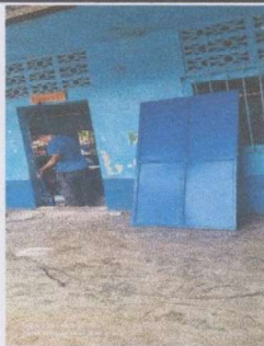
Foto1: Describir la actividad de la fotografía: Preparación del área para instalación de nueva puerta.
