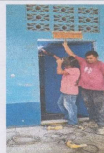
Foto 4: Describir la actividad de la fotografía: Reforzamiento de marco para tope de puerta.
