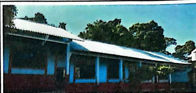
Foto 2: Sustitución de cubierta de lámina modulo 1
