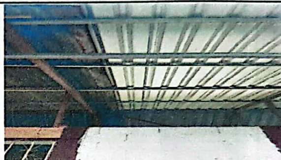
Foto 4: Sustitución de estructura metálica de techo modulo 1
