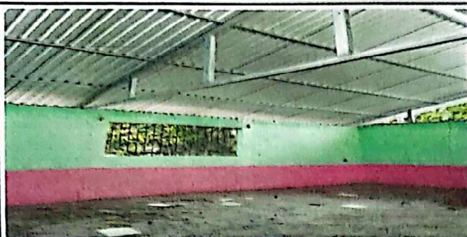
Foto 1: Sustitución de cubierta de lámina modulo 1
