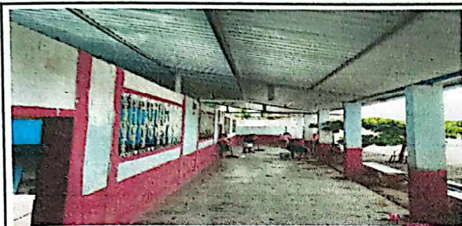
Foto 3: Sustitución de estructura metálica de techo modulo 1
