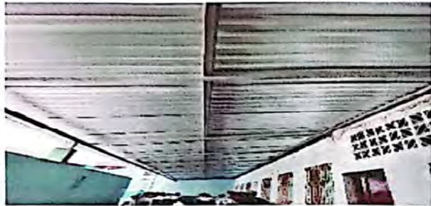
Foto 1: Suministro y sustitución de estructura de techo con costanera galvanizada
