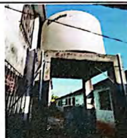
Foto 8: Suministro e instalación de deposito de agua 2500L
