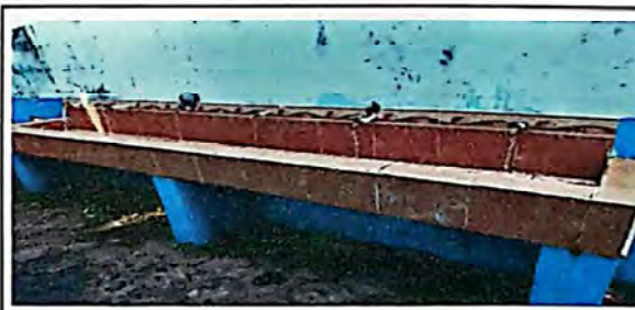
Foto 12: Suministro y sustitución de llave en lavamanos
