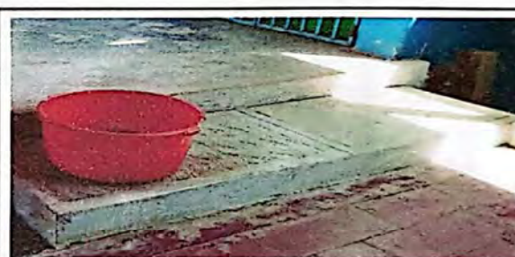
Foto 10: Suministro y reparación de gradas de concreto
