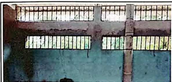
Foto 11: Suministro y instalación de balcón en cocina
