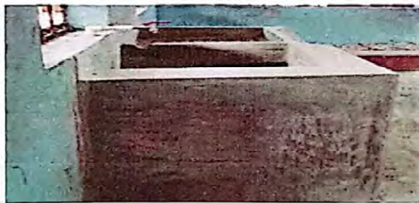
Foto 3: Suministro e instalación de pila de concreto
