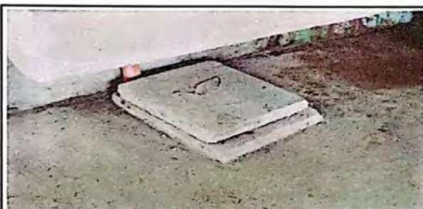
Foto 9: Suministro y reparación de drenaje de pila
