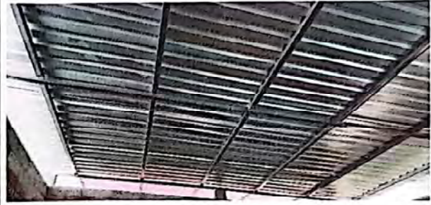
Foto 2: Suministro y sustitución de lamina troquelada C26
