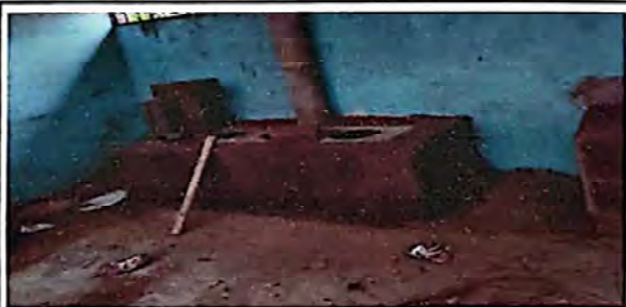
Foto 6: Suministro e instalación de forro de baldosas de barro en estufa rural
