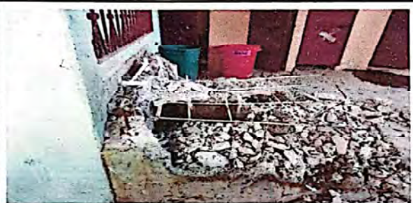
Foto 3: Suministro e instalación de pila de concreto
