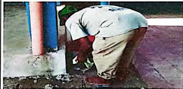
Foto 10: Suministro y reparación de gradas de concreto
