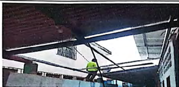
Foto 1: Suministro y sustitución de estructura de techo con costanera galvanizada
