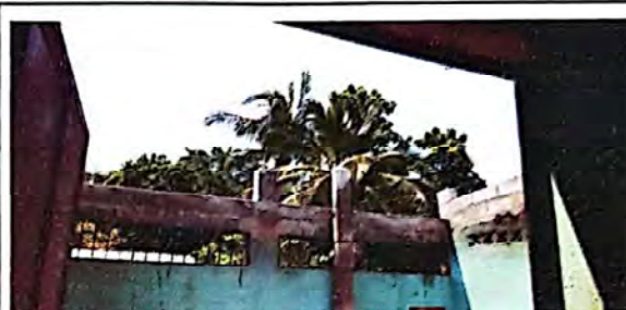
Foto 2: Suministro y sustitución de lamina troquelada C26
