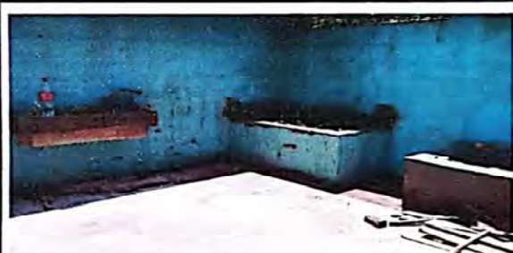
Foto 4: Suministro e instalación de mesa flotante de concreto cocina
