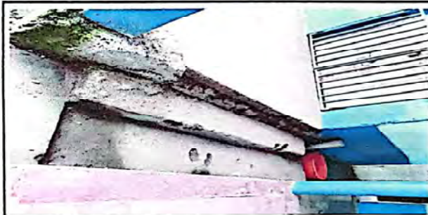
Foto 10: Suministro y reparación de gradas de concreto
