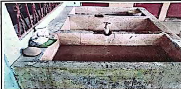
Foto 3: Suministro e instalación de pila de concreto
