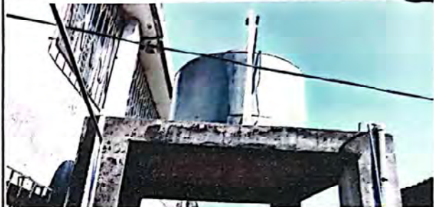
Foto 8: Suministro e instalación de depósito de agua 2500L
