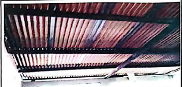
Foto 2: Suministro y sustitución de lamina troquelada C26
