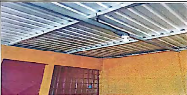
FOTO 9: Suministro e instalación de sistema eléctrico 150 mts
