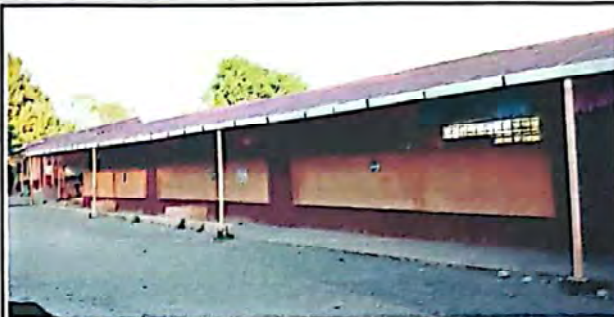
FOTO 14: Suministro y reparación de canales
