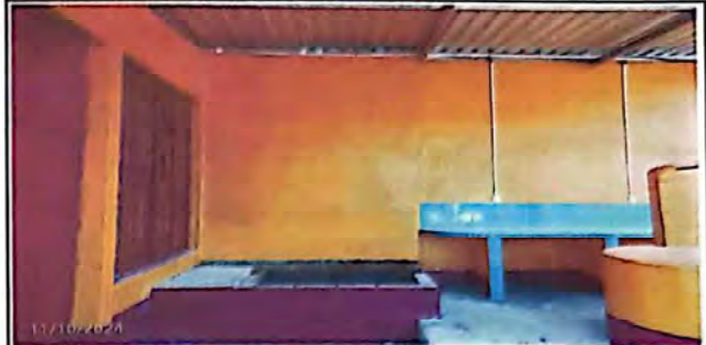
FOTO 8: Mantenimiento y remodelación de cocina
