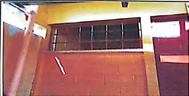
FOTO 13: Suministro y reparación de balcón de metal
