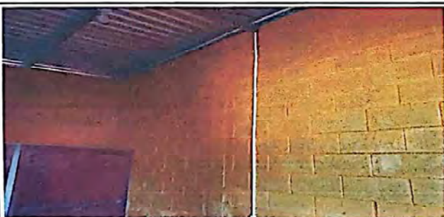
FOTO 5: Suministro y reparación de pared de cocina
