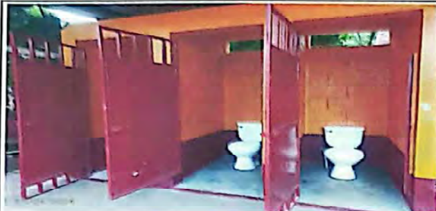
FOTO 1: Suministro e instalación de sanitarios lavables
