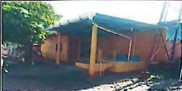
FOTO 7: Suministro e instalación de columnas
