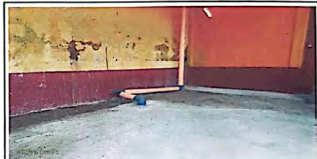
FOTO 10: Mantenimiento de fosa séptica
