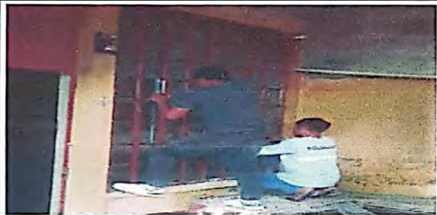
FOTO 9: Suministro e instalación de sistema eléctrico 150 mts
