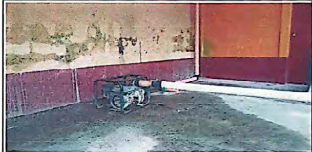
FOTO 10: Mantenimiento de fosa séptica
