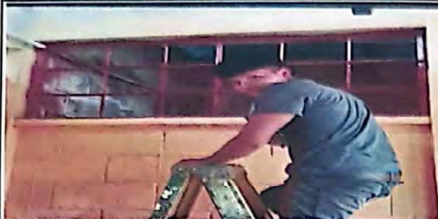
FOTO 13: Suministro y reparación de balcón de metal
