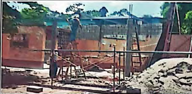
FOTO 7: Suministro e instalación de columnas
