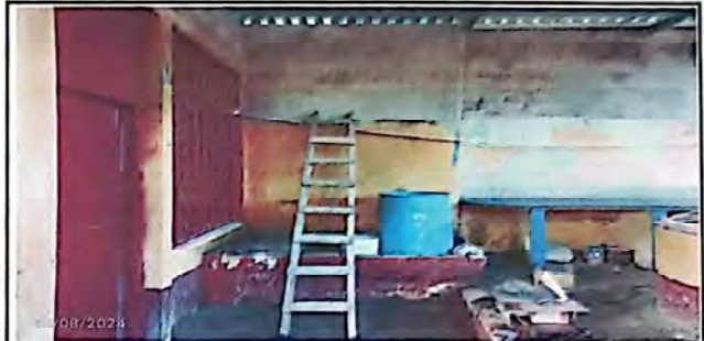
FOTO 8: Mantenimiento y remodelación de cocina
