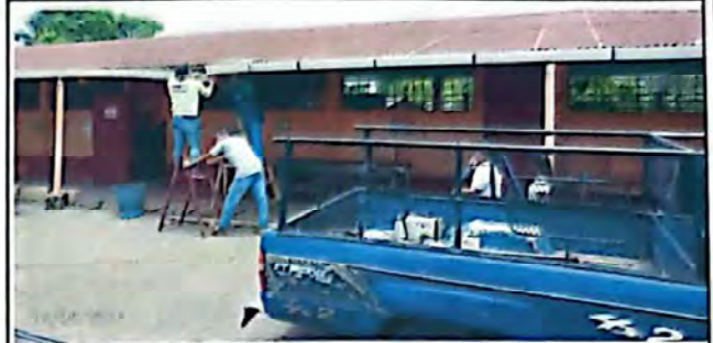
FOTO 14: Suministro y reparación de canales
