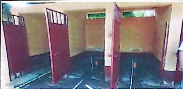
FOTO 1: Suministro e instalación de sanitarios lavables
