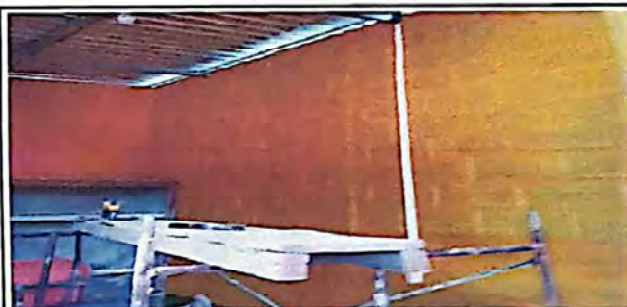
FOTO 5: Suministro y reparación de pared de cocina
