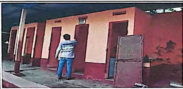
FOTO 11: Mantenimiento de pintado de puertas
