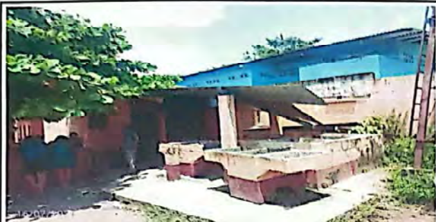
FOTO 7: Suministro e instalación de columnas
