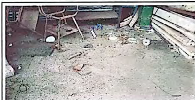
FOTO 10: Mantenimiento de fosa séptica
