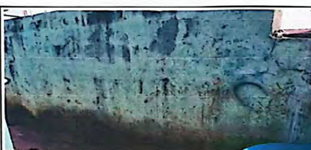
FOTO 6: Suministro y repello de pared de cocina
