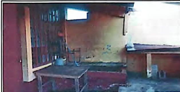
FOTO 8: Mantenimiento y remodelación de cocina
