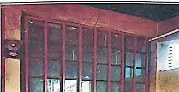
FOTO 9: Suministro e instalación de sistema eléctrico 150 mts
