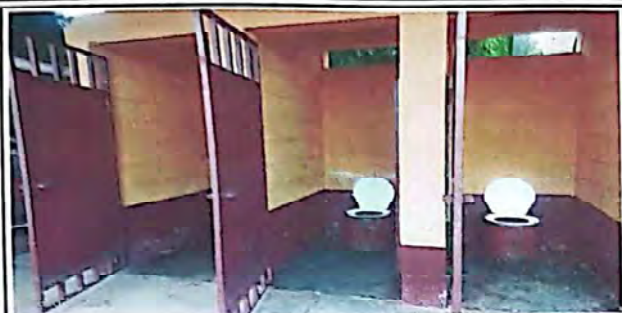
FOTO 1: Suministro e instalación de sanitarios lavables
