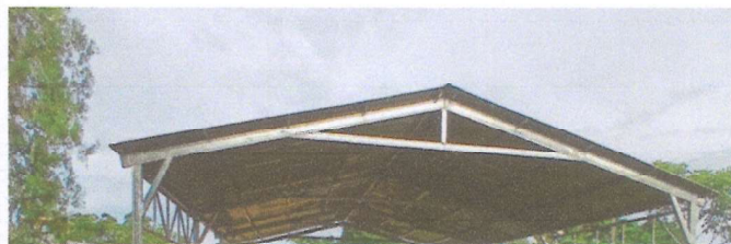
Foto 2: Suministro e instalacion de estructura metálica soporte de cubierta con perfiles metalicos (costaneras)
