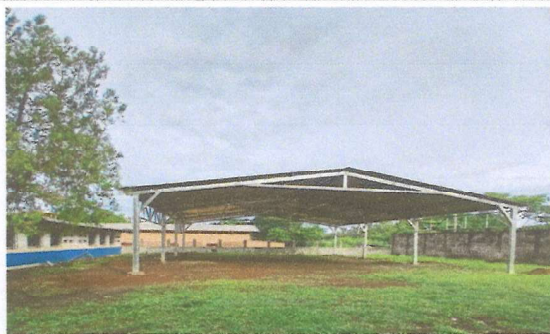
Foto 3: Suministro e instalación de lamina troqueleada calibre 26 Modulo 3
