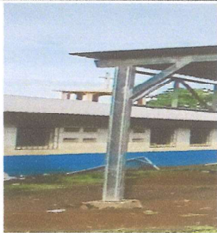
Foto 1: Suministro e instalacion de estructuras metálicas de columnas con perfiles metálicos
