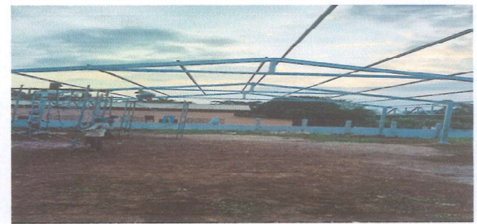
Foto 4: Suministro e instalacion de estructura metálica soporte de cubierta con perfiles metálicos (costaneras)
