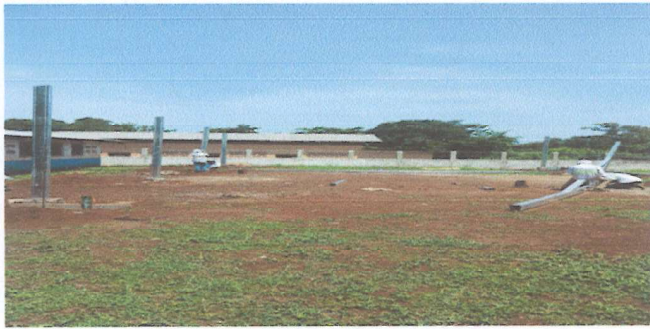
Foto 1: Suministro e instalacion de estructuras metálicas de columnas con perfiles metálicos
