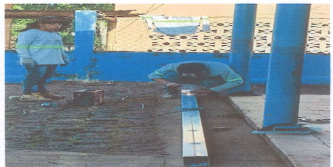
Foto 2: Suministro e instalacion de columnas metálicas
