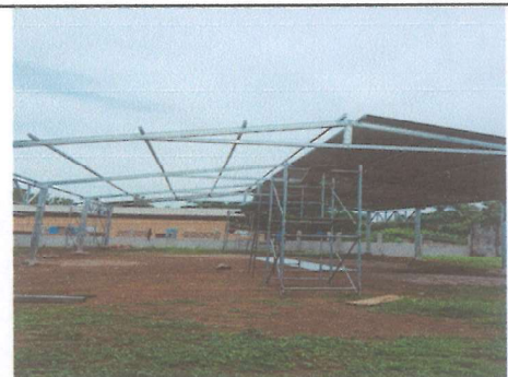
Foto 6: Suministro e instalación de lamina troqueleada calibre 26 Modulo 3
