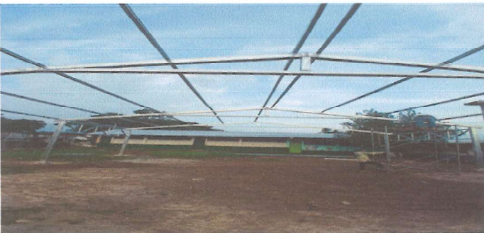
Foto 3: Suministro e instalacion de estructura metálica soporte de cubierta con perfiles metálicos (costaneras)
