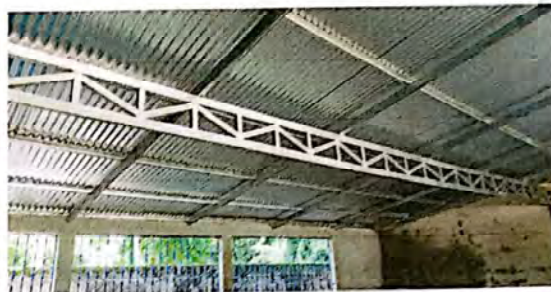
Aplicación de estructura de Soportía para aula
