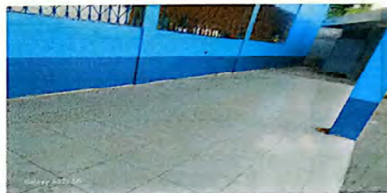
Suministro e instalación de piso ceramico 22 mt2 para pasillo
