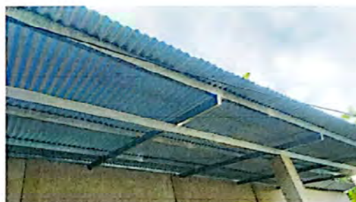
Suministro e instalación de lámina para pasillo
