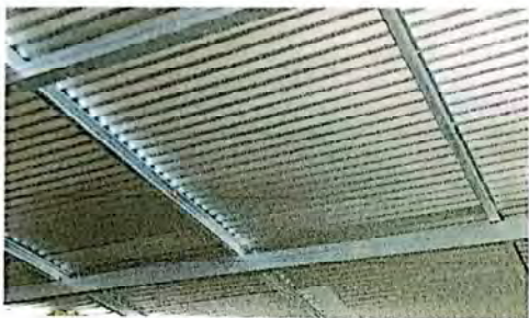
suministro e instalación de estructura de soporte de metal
