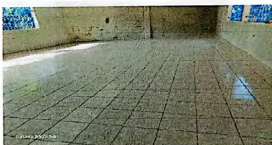
suministro e instalación de piso ceramico para aula 92mts2
