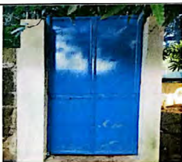
Suministro e instalación de puerta de metal de emergencia
