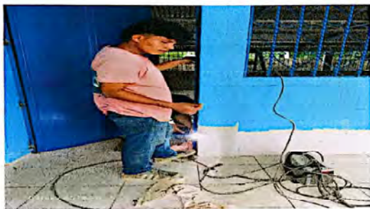
Reparación e instalación de puerta de metal para aula
