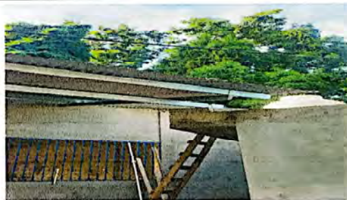
Suministro e instalacion de lámina para pasillo
