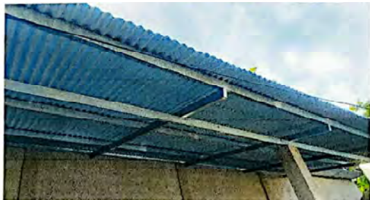
suministro e instalación de estructura de soporte de metal
