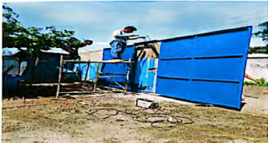
sustitucion e instalación de portón
