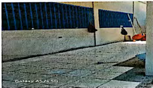
suministro e instalación de piso cerámico para aula 92mts2
