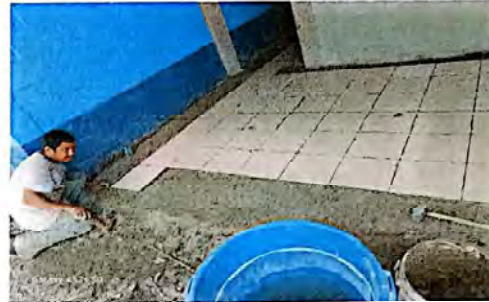
Suministro e instalación de piso cerámico 22 mt2 para pasillo
