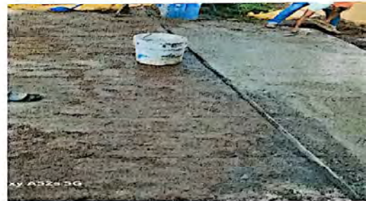
suministro e instalación de torta de concreto para piso de aula 92 mts2
