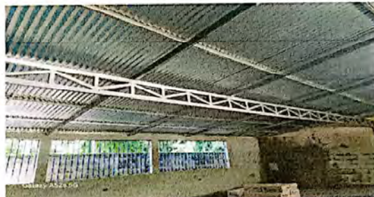
Aplicación de estructura de Soporte para aula
