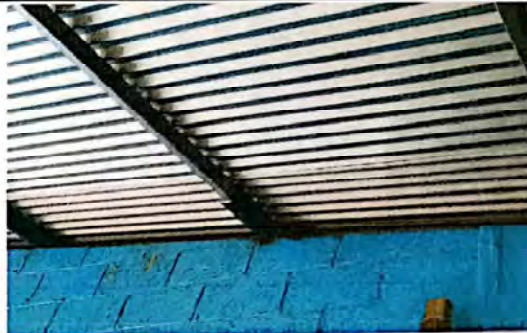
Aplicación de estructura de Soporte para aula
