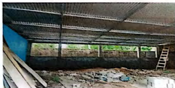
suministro e instalación de piso cerámico para aula 92mts2
