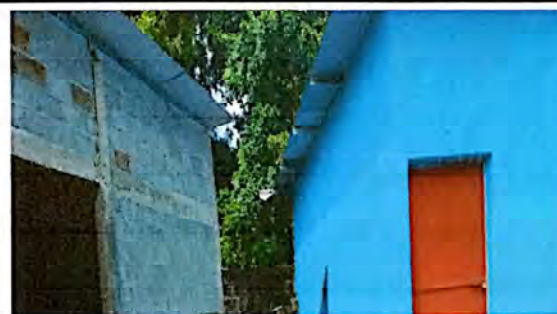
Suministro e instalacion de lámina para pasillo
