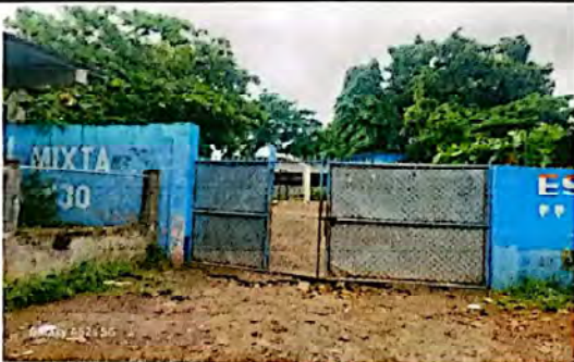
sustitución e instalación de portón
