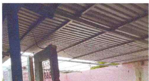
Foto 5: SUMINISTRO Y SUSTITUCIÓN DE LÁMINA POR LÁMINA TROQUELADA.
