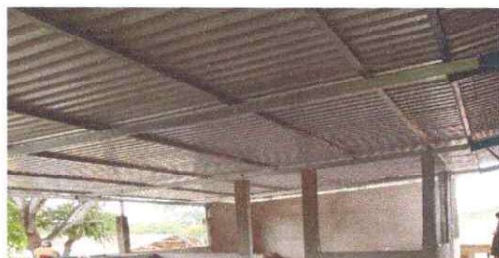
Foto 1: SUMINISTRO Y SUSTITUCIÓN DE LÁMINA POR LÁMINA TROQUELADA.
