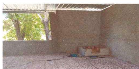
Foto 4: SUMINISTRO Y SUSTITUCIÓN DE ESTUFA RURAL
