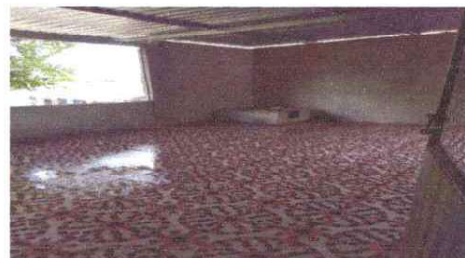
Foto 2: SUMINISTRO Y SUSTITUCIÓN DE TORTA DE CEMENTO POR PISO CERÁMICO EN COCINA
