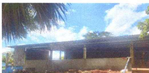
Foto 3: SUMINISTRO Y REPARACION DE MURO DE BLOCK DE COCINA.
