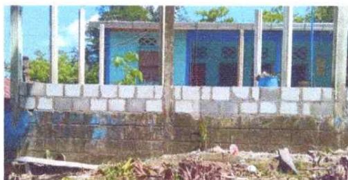
Foto 3: SUMINISTRO Y REPARACION DE MURO DE BLOCK DE COCINA.
