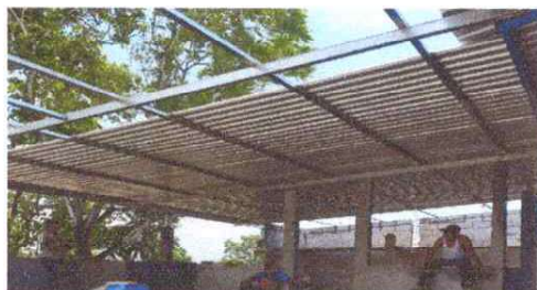
Foto 1: SUMINISTRO Y SUSTITUCIÓN DE LÁMINA POR LÁMINA TROQUELADA.
