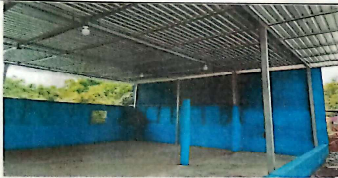
Foto 3: SUSTITUCIÓN DE ESTRUCTURA DE MADERA POR ESTRUCTURA METÁLICA
