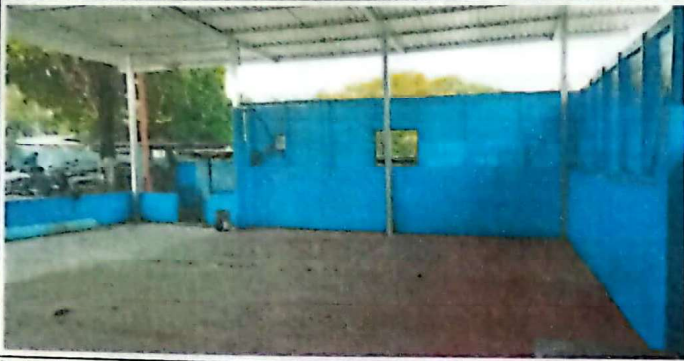
Foto 1: SUSTITUCIÓN DE BASES DE MADERA POR BASES DE METAL, EN SALON DE ESCUELA
