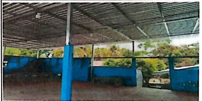
Foto 4: SUSTITUCIÓN DE ESTRUCTURA DE MADERA POR ESTRUCTURA METÁLICA
