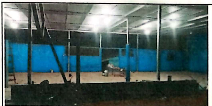
Foto 6: SUSTITUCIÓN DE PLAFONERAS, CABLEADO Y TUBO EN SALON DE ESCUELA
