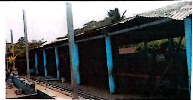
Foto 4: SUSTITUCIÓN DE ESTRUCTURA DE MADERA POR ESTRUCTURA METÁLICA
