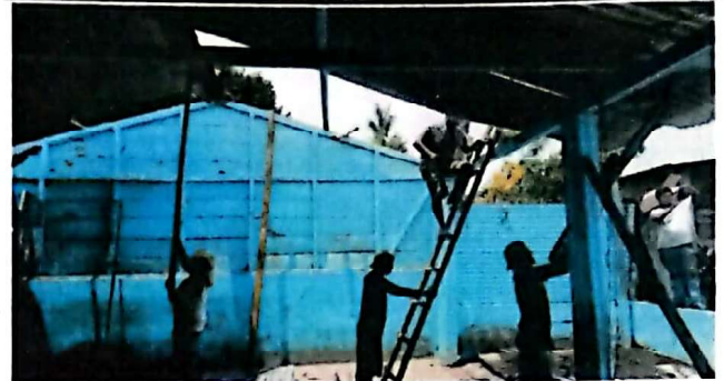
Foto 2: SUSTITUCIÓN DE COBERTURA DE LAMINA ACANALADA POR LAMINA TROQUELADA, EN SALON DE ESCUELA
