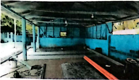
Foto 1: SUSTITUCIÓN DE BASES DE MADERA POR BASES DE METAL, EN SALON DE ESCUELA
