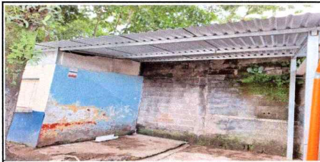
Foto 6: Sustitución de Cubierta de Lámina para nueva Galera, ampliacion de cocina.
