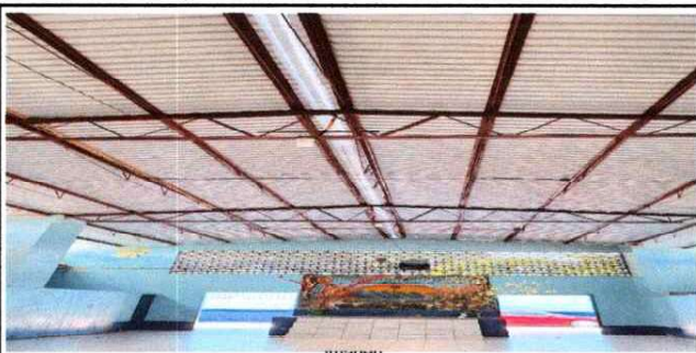
Foto 1: Sustitución de Cubierta de Lámina ya finalizada Módulo I de la EOUM Tipo Guatemala
