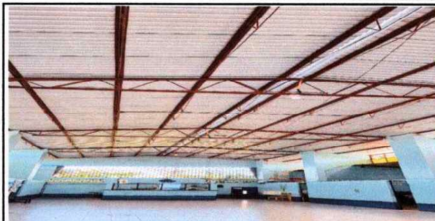
Foto 2: Trabajo Finalizado Sustitución de Cubierta de Lámina Módulo I.
