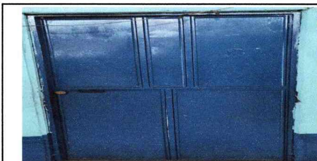
Foto 4: Sustitución Chapa Yale de la puerta de Tercero A Módulo I.
