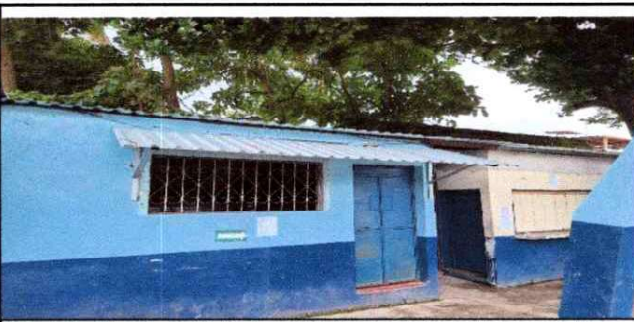
Foto 5: Sustitución de Cubierta de Lámina de Cocina y Tienda escolar.
