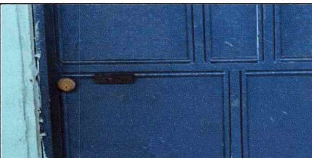
Foto 3: Sustitución de Chapa Yale de la puerta de la entrada principal Módulo I.
