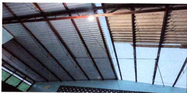
Foto 1: Retiro de cubierta de lámina de Duralita Módulo I
