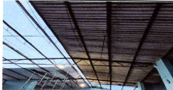
Foto 2: Mantenimiento de estructura metálica Módulo I
