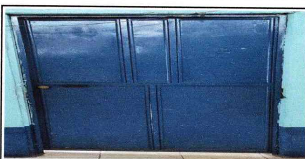
Foto 4: Cambio de Chapa Yale Módulo I.
