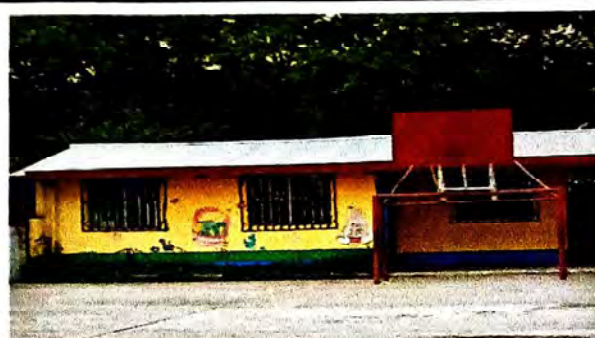
Foto 2: Láminas instaladas en el módulo 1, primer nivel del centro educativo.
