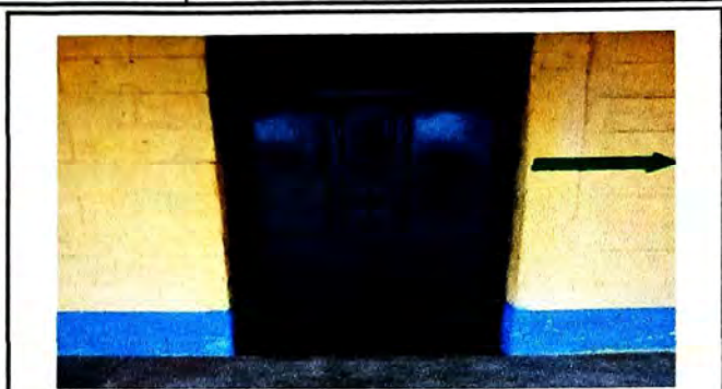
Foto 8: Mantenimiento de puerta de metal, lijado y aplicación de pintura, realizado.
