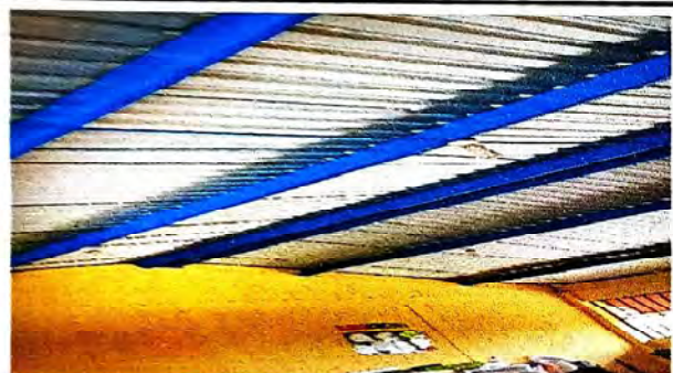
Foto 3: Mantenimiento realizado en estructuras de soporte de metal, lijado y aplicación de pintura módulos 1 y 2.
