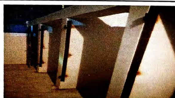
Foto 6: Muros de tabique instalados en servicios sanitarios.
