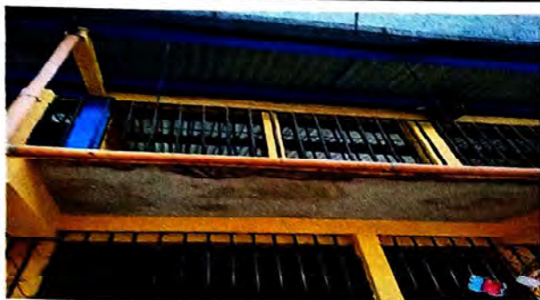
Foto 1: Láminas instaladas en el módulo 1, segundo nivel del centro educativo.
