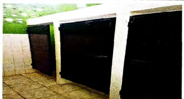
Foto 5: Puertas instaladas en servicios sanitarios.
