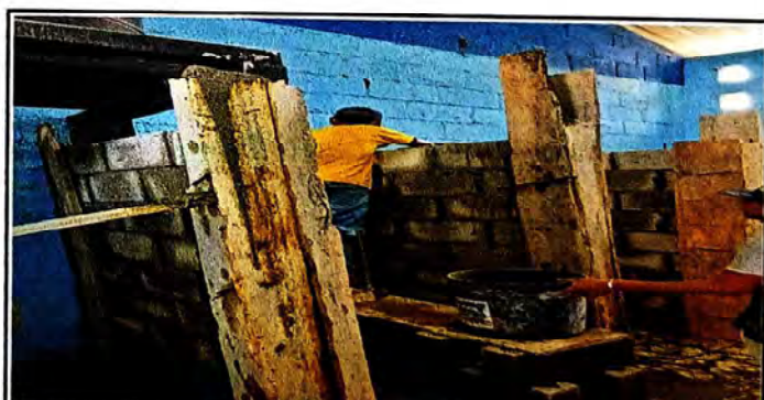
Foto 6: Sustitución de muros de láminas por tabiques
