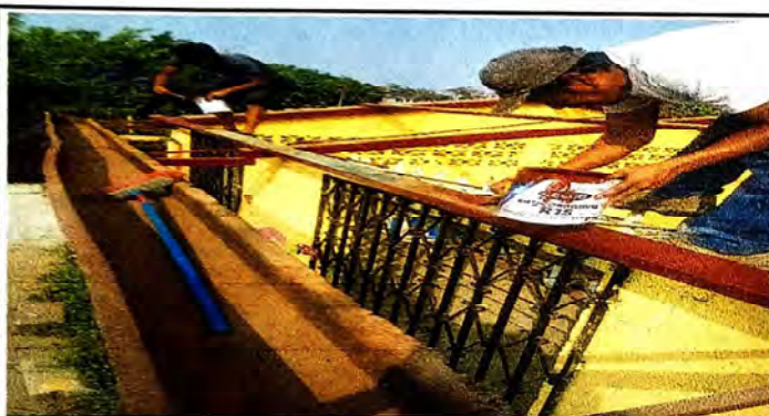
Foto 3: Mantenimiento de estructura de soporte de metal, lijado y aplicación de pintura en toda la estructura, módulos 1 y 2
