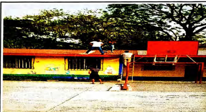
Foto 2: Inicio de sustitución de cubierta de lámina módulo 2
