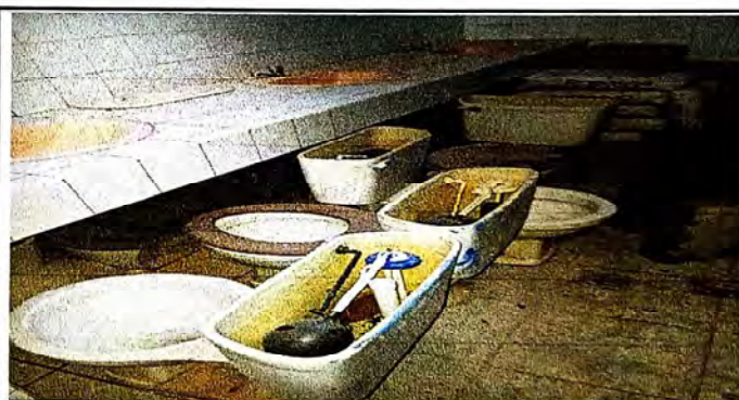
Foto 4: Sustitución de inodoros
