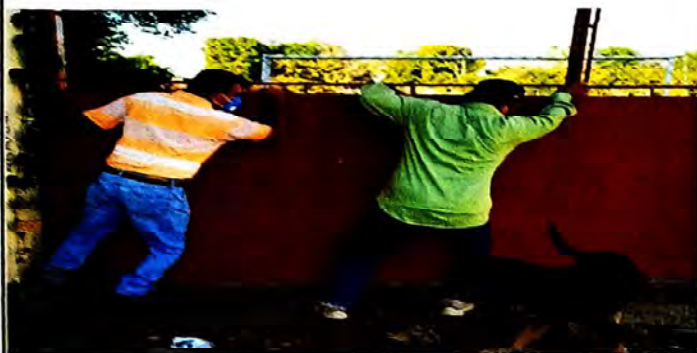
Foto 7: Sustitución de portón de metal.
