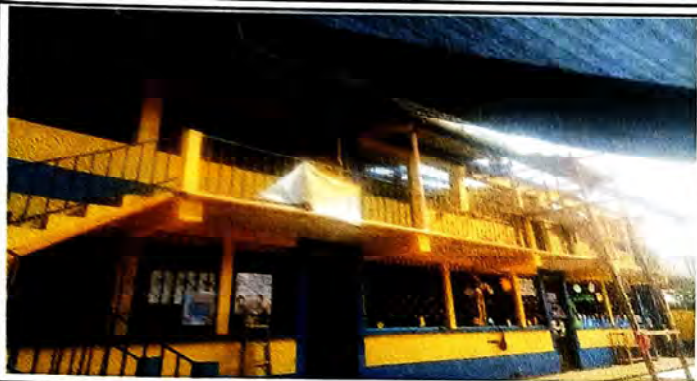
Foto 1: Inicio de sustitución de cubierta de lámina módulo 1
