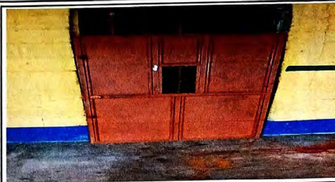
Foto 8: Mantenimiento a estructura de puerta de metal, lijado y aplicación de pintura.
