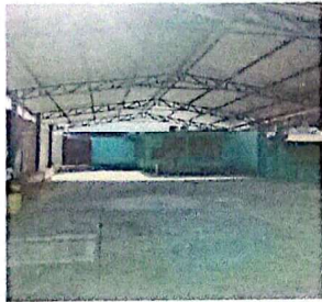
Foto 3: SUSTITUCIÓN DE LÁMINA, CANCHA #2
