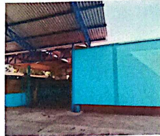
Foto 4: SUSTITUCIÓN DE ESTRUCTURA METÁLICA, CANCHA #2
