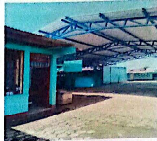
Foto 2: SUSTITUCIÓN DE ESTRUCTURA METÁLICA DE CANCHA #2 PINTURA PARA AULA
