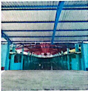
Foto 1: SUSTITUCIÓN DE ESTRUCTURA METÁLICA DE CANCHA #2 PINTURA PARA AULA
