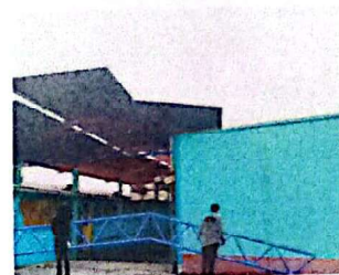
Foto 4: SUSTITUCIÓN DE ESTRUCTURA METÁLICA, CANCHA #2
