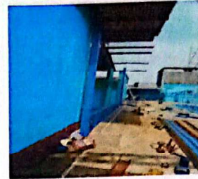
Foto 2: SUSTITUCIÓN DE ESTRUCTURA METÁLICA DE CANCHA #2 PINTURA DE AULA
