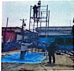
Foto 3: SUSTITUCIÓN DE LÁMINA, CANCHA #2
