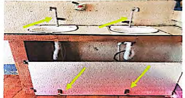
Foto 4: Suministros e instalación de llaves de pedal, grifo de metal y estructura metálica. Lavamanos
