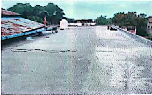
Foto 1: Foto 1: Instalación de la aplicación de mezclón de 416 metros cuadrados en terraza segundo nivel.
