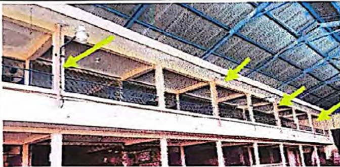
Foto 3: Instalación de 6 bajadas de agua pluvial.
