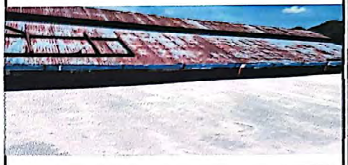
Foto 2: Reparación y mantenimiento de metros lineales y canales de pvc.
