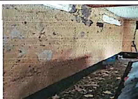
Foto 6: Pintura interior de aulas.
