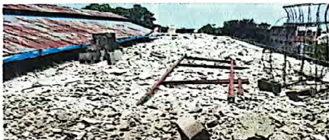
Foto 1: Foto 1: Instalación de la aplicación de mezlón de 416 metros cuadrados en terraza segundo nivel.
