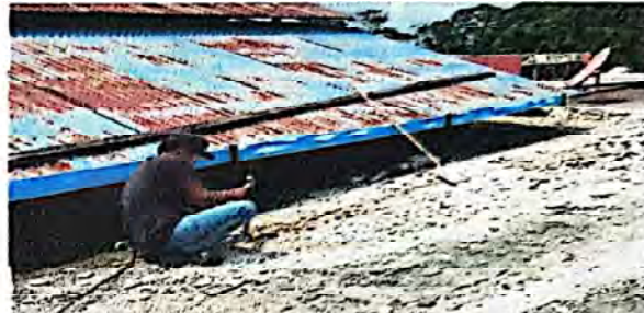
Foto 2: Reparación y mantenimiento de metros lineales y canales de pvc.
