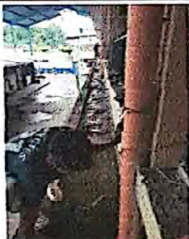
Foto 3: Instalación de 6 bajadas de agua pluvial.
