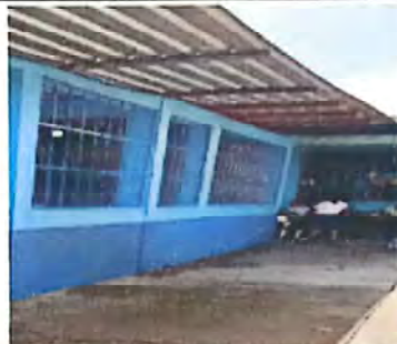
Foto 4: Suministro y sustitucion de balcones de metal
