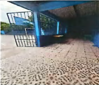
FOTO 3: Sustitucion de piso de torta de cemento por piso ceramico
