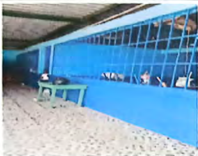
Foto 3: Suministro y sustitucion de balcones de metal
