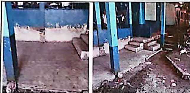
Foto 1: Suministro de piso de concreto ,gradas de concreto y repello de pared.
