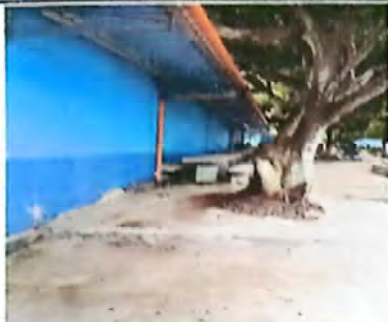
Foto 1: Suministro de lamina troqueleada aluzinc calibre 26
