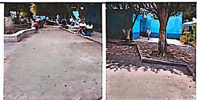
Foto 3: Suministro de piso de concreto para exterior.
