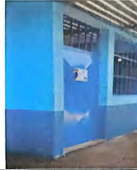
Foto 2: Sustitucion de puerta metalica
