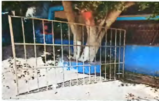
Foto 3: Suministro y sustitucion de balcones de metal
