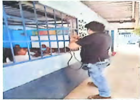
Foto 2: Suministro y sustitucion de balcones de metal
