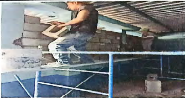
Foto 1: Suministro y reparación de muro de block
