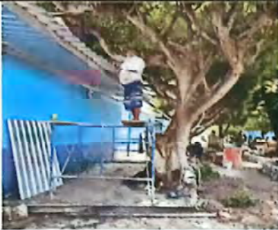
Foto 1: Suministro de lamina troqueleada aluzinc calibre 26
