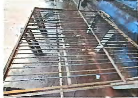
Foto 4: Suministro y sustitucion de balcones de metal
